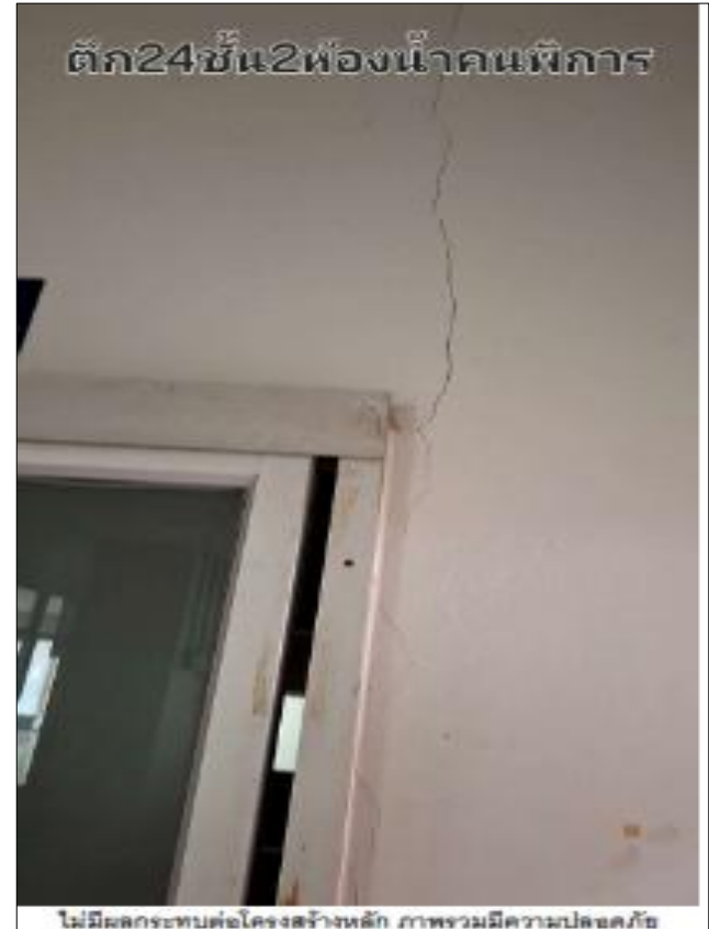
ไม่มีผลกระทบต่องานโครงสร้างหลัก ภาพรวมมีความปลอดภัย
